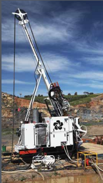
Equipos de perforación diamantina
